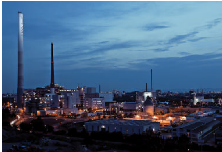
Heizkraftwerk Nord der RHE AG
